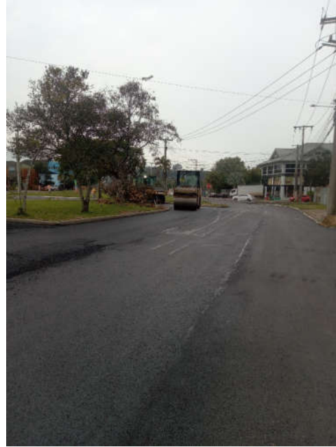
Figura 47 – execução de meio-fio e camada CBUQ
