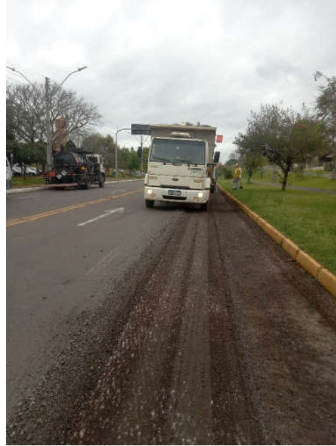
Figura 7 – recuperação do pavimento (fresagem)
