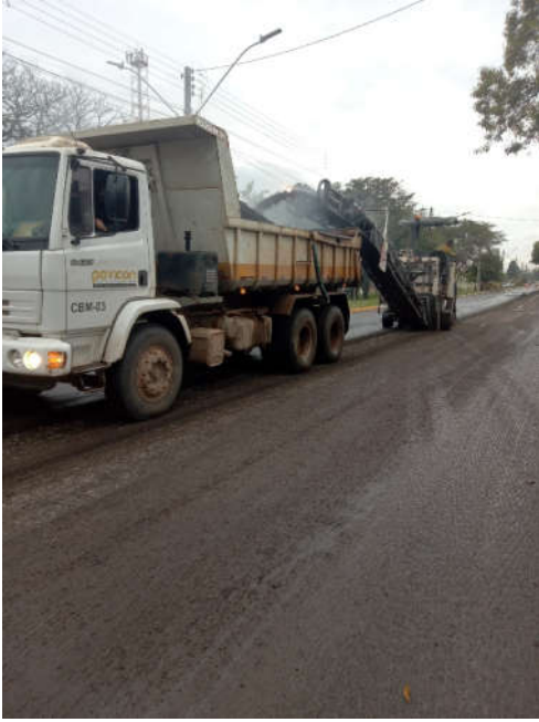
Figura 21 – recuperação do pavimento (fresagem)
