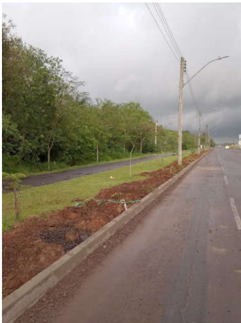
Figura 49 – execução de meio-fio
