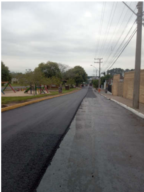
Figura 46 – execução de camada CBUQ
