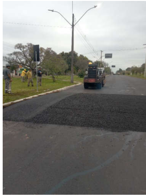
Figura 44 – execução de lombadas e camada CBUQ
