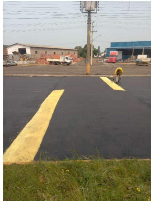
Figura 40 – execução de lombadas e sinalização horizontal
