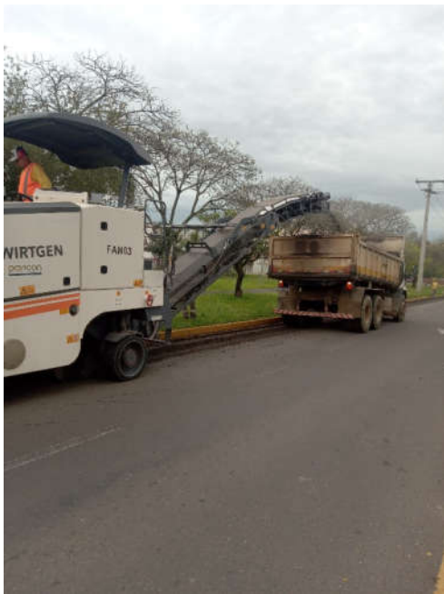
Figura 6 – recuperação do pavimento (fresagem)
