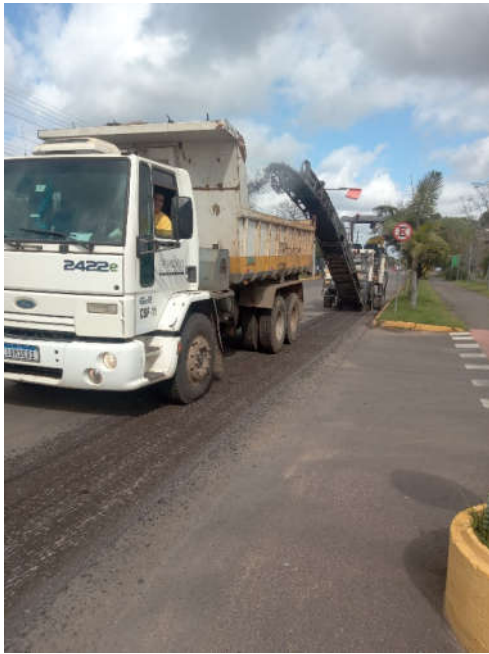
Figura 10 – recuperação do pavimento (fresagem)
