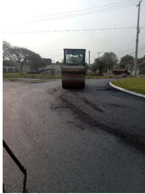
Figura 35 – execução de camada CBUQ
