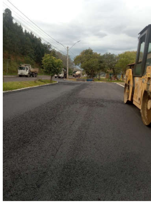
Figura 27 – execução de camada CBUQ
