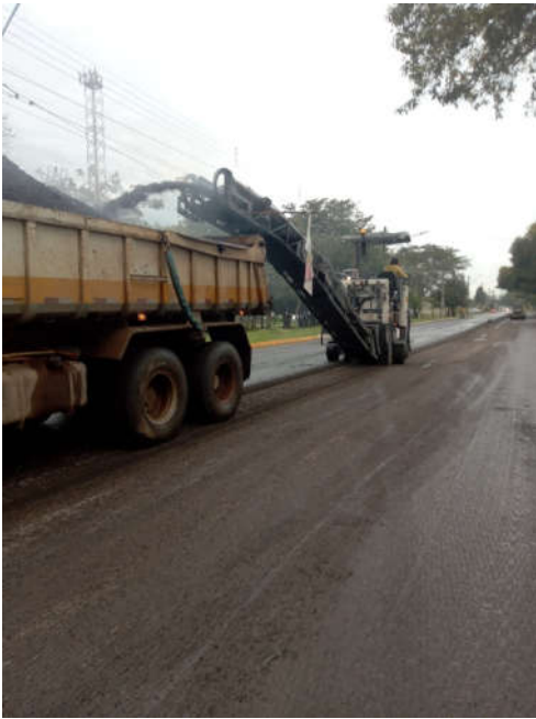
Figura 22 – recuperação do pavimento (fresagem)
