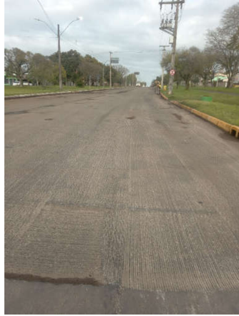
Figura 11 – recuperação do pavimento (fresagem)
