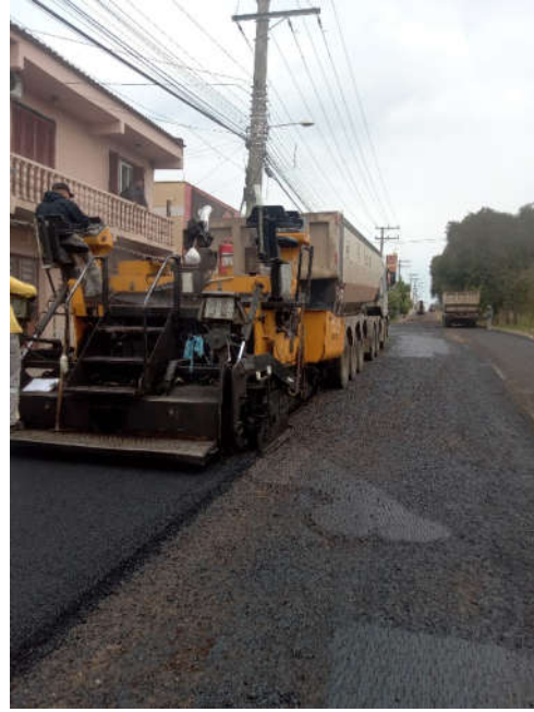
Figura 43 – execução de camada CBUQ
