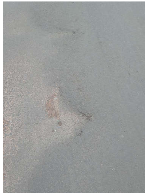
Figura 4 – recuperação do pavimento
