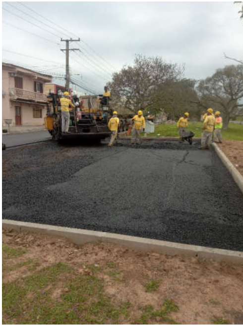
Figura 42 – execução de meio-fio e camada CBUQ
