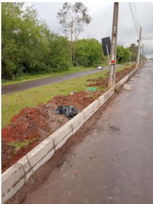
Figura 50 – execução de meio-fio
