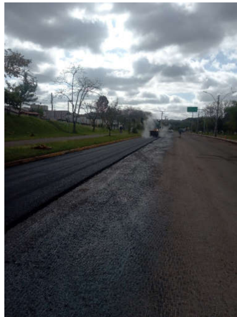
Figura 16 – execução de camada CBUQ
