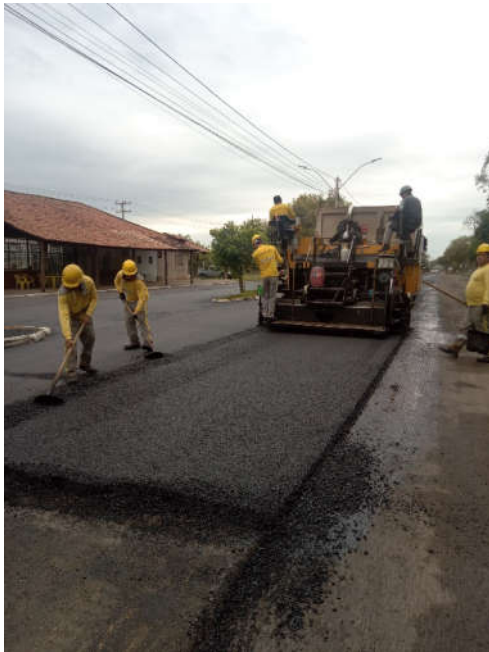
Figura 26 – execução de camada CBUQ
