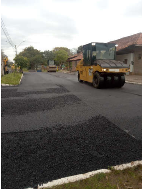
Figura 25 – execução de camada CBUQ
