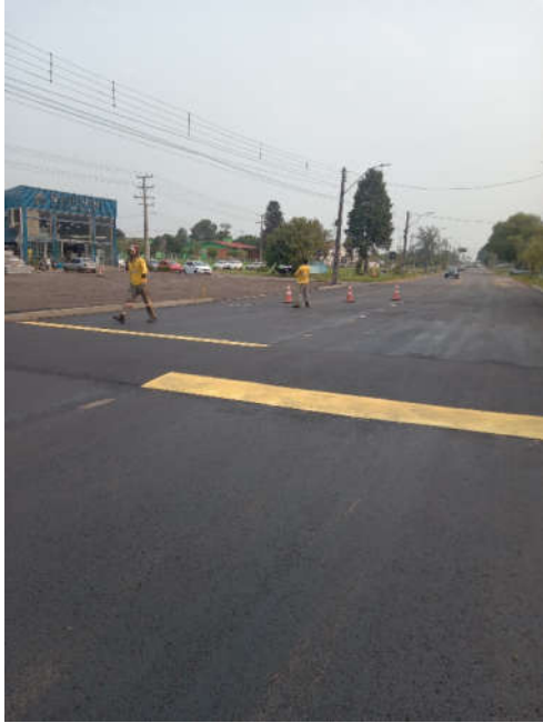
Figura 37 – execução de lombadas e sinalização horizontal
