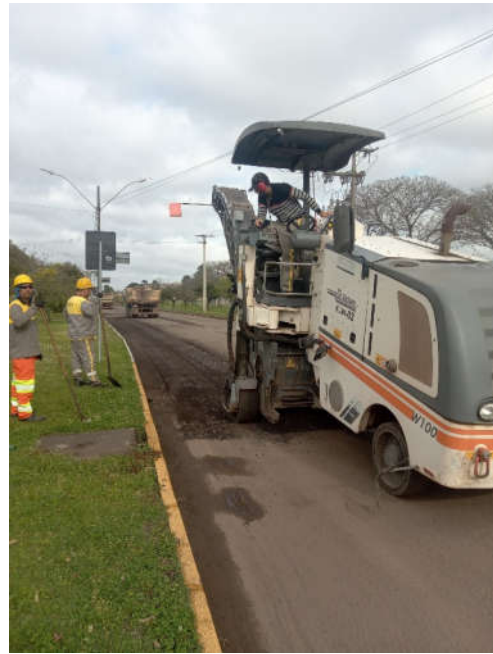
Figura 12 – recuperação do pavimento (fresagem)
