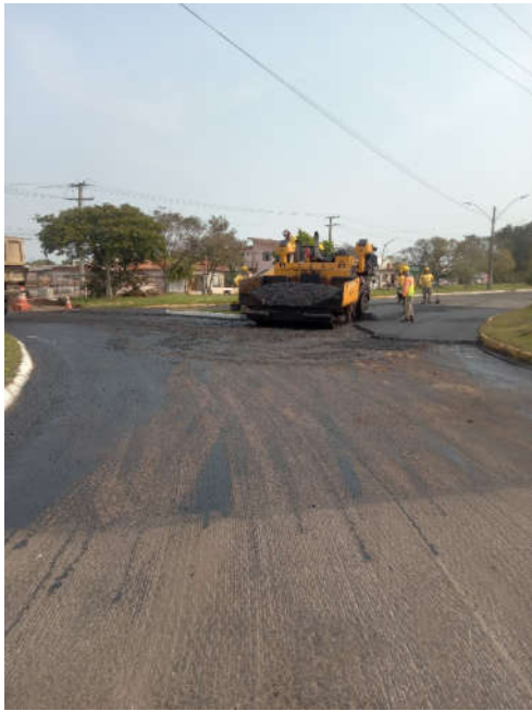
Figura 34 – execução de camada CBUQ
