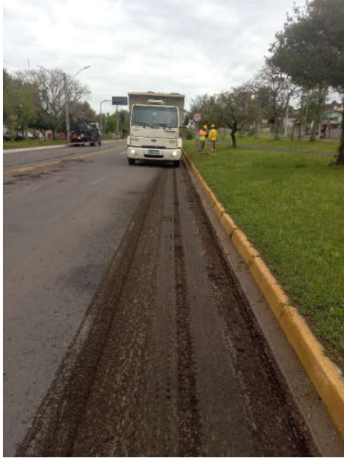
Figura 5 – recuperação do pavimento (fresagem)
