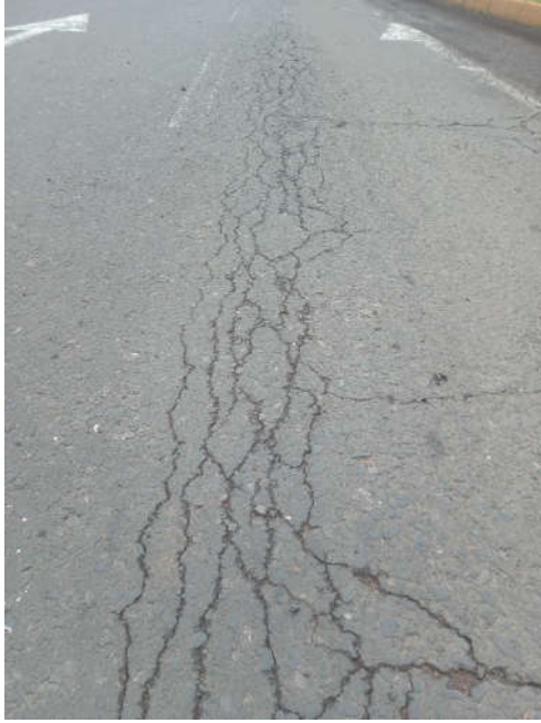
Figura 1 – recuperação do pavimento
