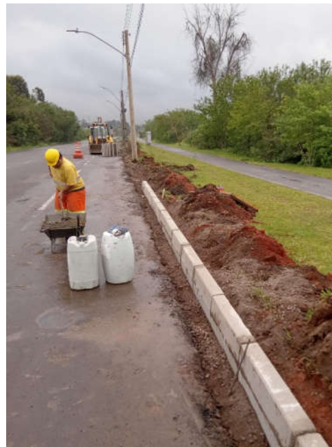
Figura 51 – execução de meio-fio
