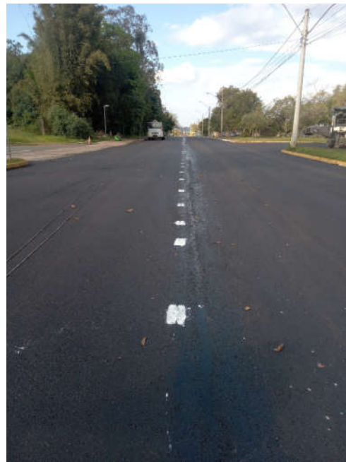
Figura 32 – execução de sinalização horizontal
