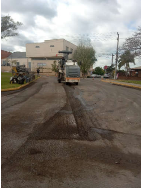
Figura 9 – recuperação do pavimento (fresagem)
