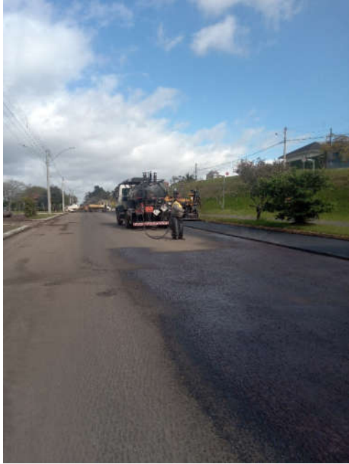
Figura 13 – execução de pintura de ligação
