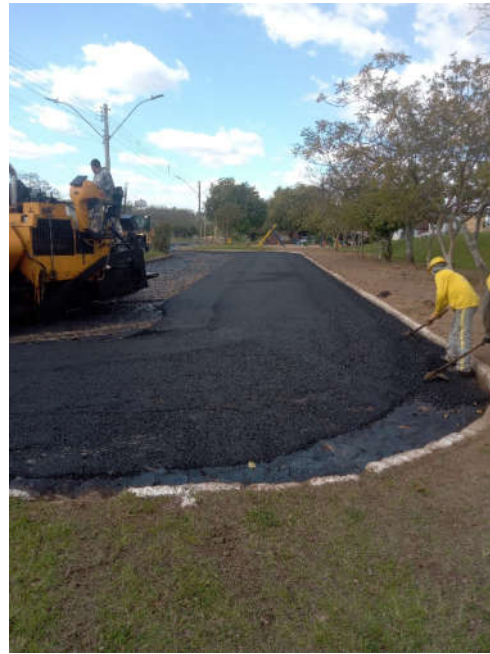
Figura 20 – execução de camada CBUQ
