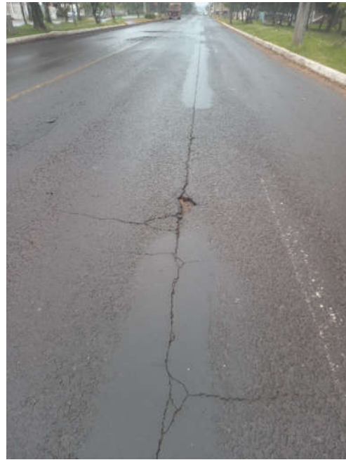
Figura 24 – recuperação do pavimento
