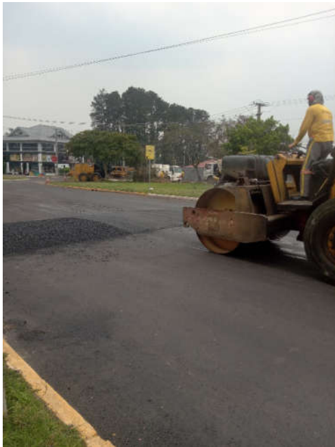
Figura 38 – execução de lombadas e sinalização horizontal
