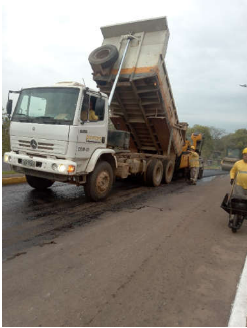
Figura 45 – execução de camada CBUQ
