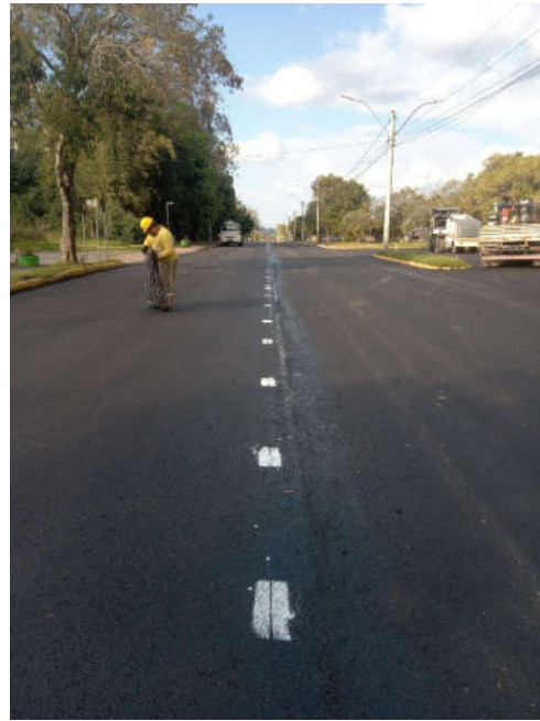
Figura 31 – execução de sinalização horizontal
