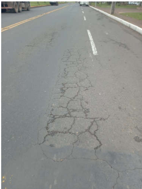
Figura 2 – recuperação do pavimento
