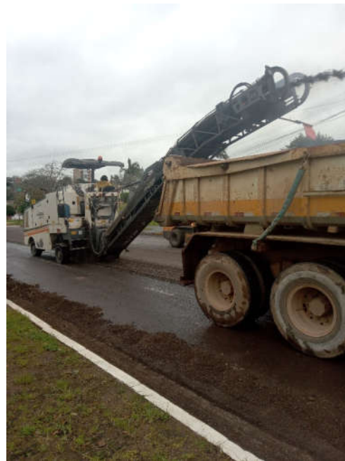
Figura 8 – recuperação do pavimento (fresagem)
