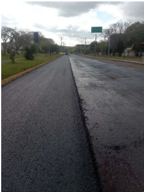
Figura 14 – execução de camada CBUQ
