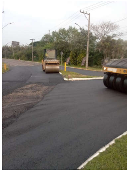
Figura 36 – execução de camada CBUQ
