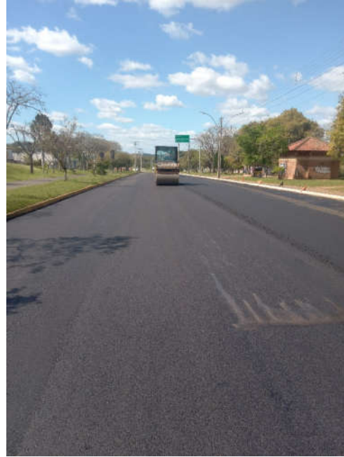
Figura 15 – execução de camada CBUQ
