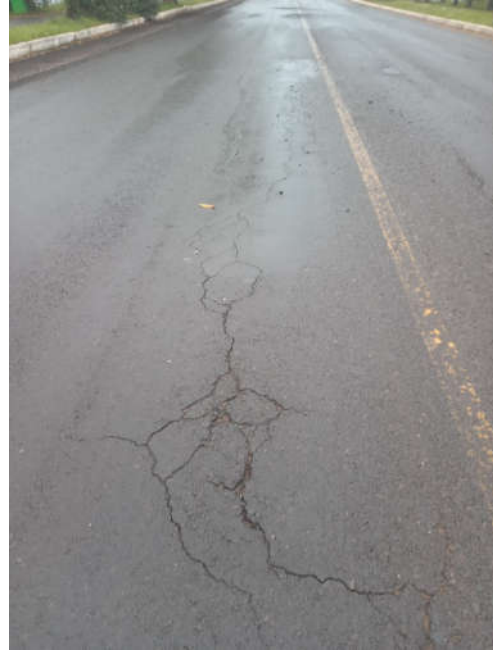
Figura 23 – recuperação do pavimento
