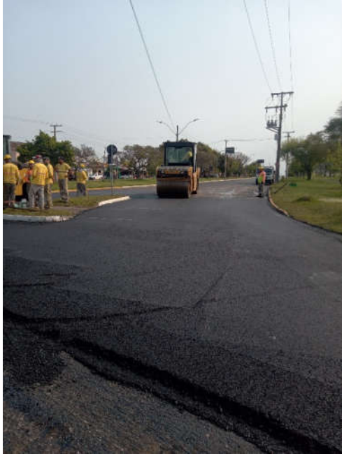
Figura 33 – execução de camada CBUQ
