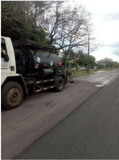
Figura 29 – execução de pintura de ligação
