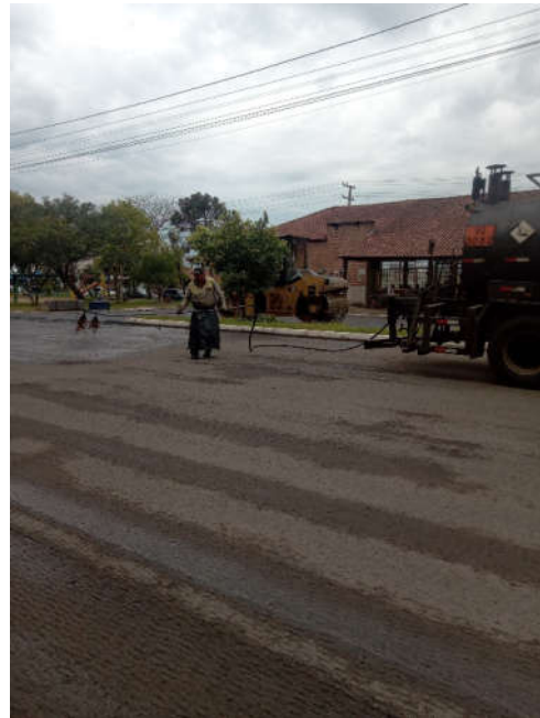
Figura 28 – execução de pintura de ligação
