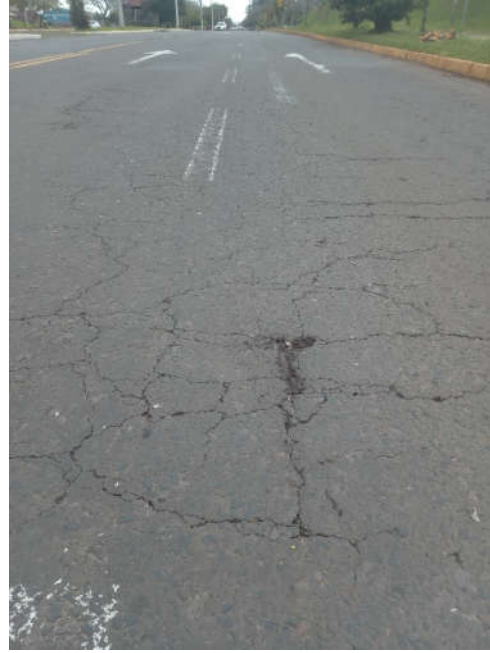
Figura 3 – recuperação do pavimento
