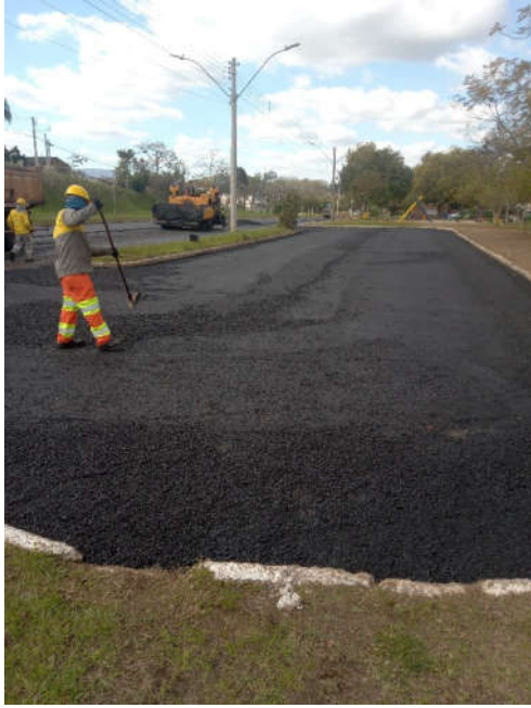
Figura 17 – execução de camada CBUQ
