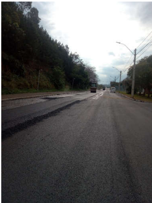
Figura 30 – execução de camada CBUQ
