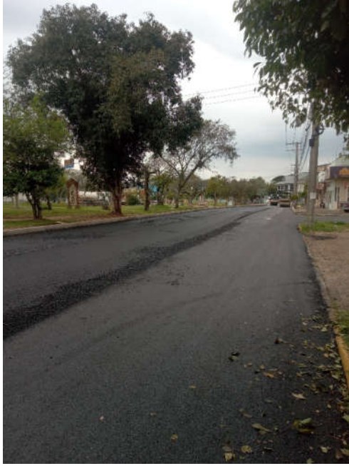
Figura 41 – execução de meio-fio e camada CBUQ
