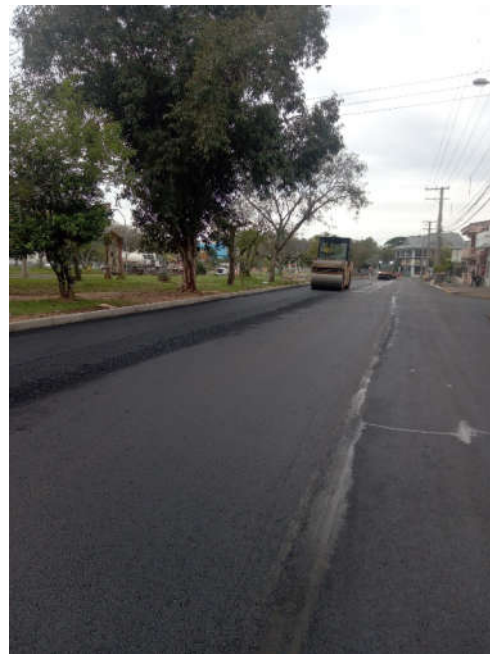
Figura 48 – execução de meio-fio e camada CBUQ
