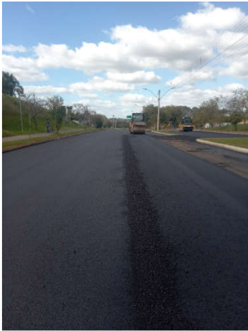
Figura 18 – execução de camada CBUQ
