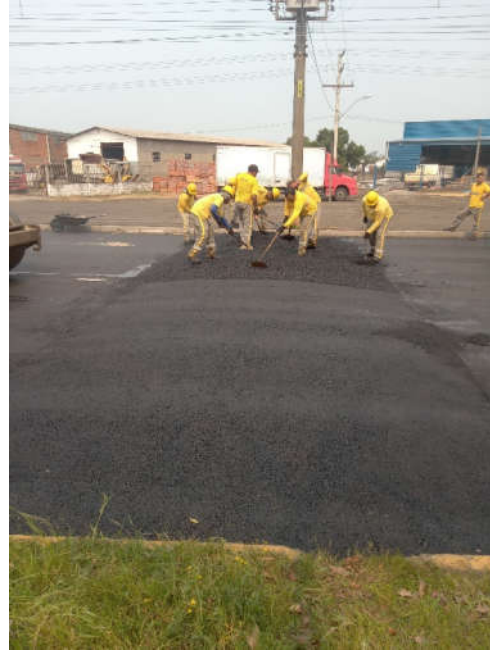
Figura 39 – execução de lombadas e sinalização horizontal
