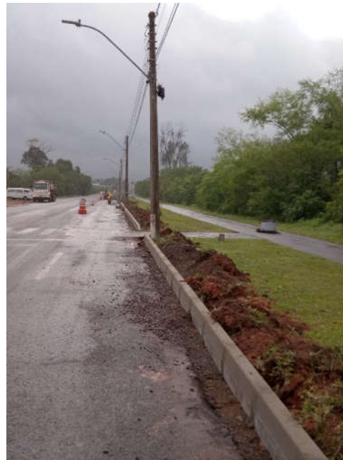
Figura 52 – execução de meio-fio
