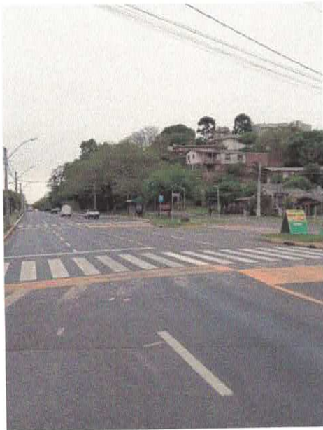
Figura 57 – Execução de sinalização horizontal
