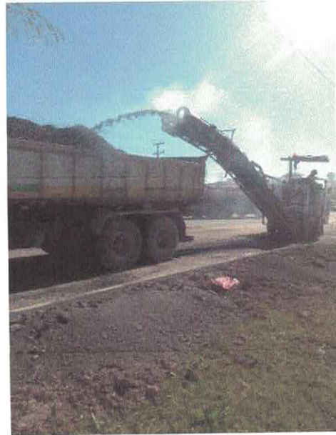
Figura 31 – Execução de fresagem
