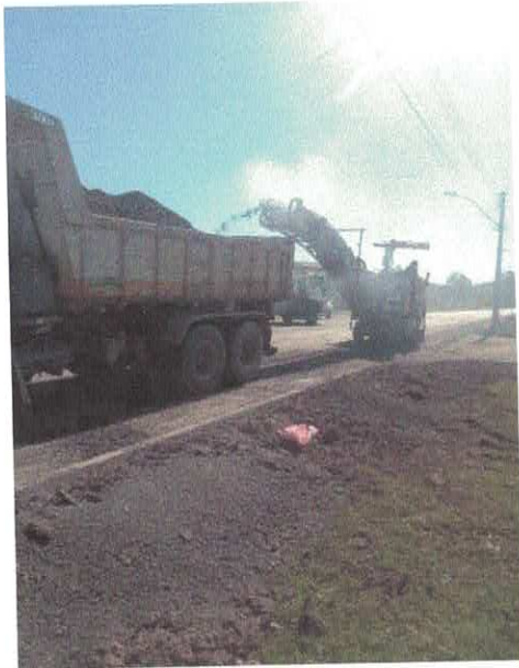
Figura 30 – Execução de fresagem
