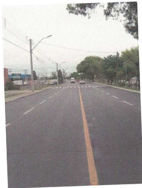
Figura 55 – Execução de sinalização horizontal
