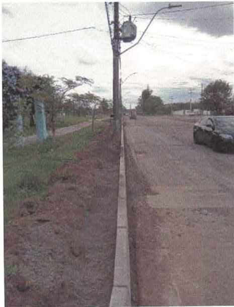
Figura 45 – Execução de meio-fio
