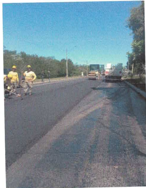
Figura 23 – Execução camada de CBUQ
