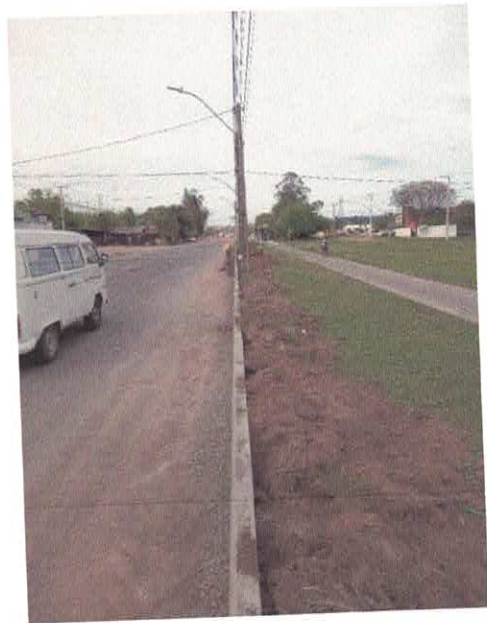
Figura 43 – Execução de meio-fio
