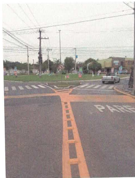
Figura 60 – Execução de sinalização horizontal
