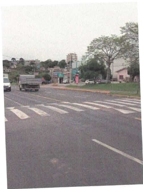
Figura 53 – Execução de sinalização horizontal
