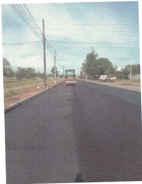
Figura 50 – Execução camada de CBUQ
