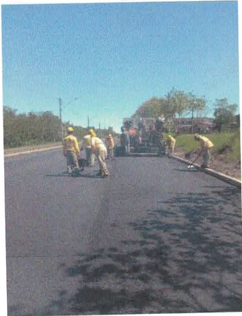
Figura 21 – Execução camada de CBUQ
