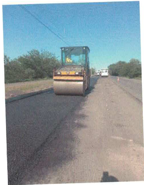
Figura 35 – Execução camada de CBUQ
