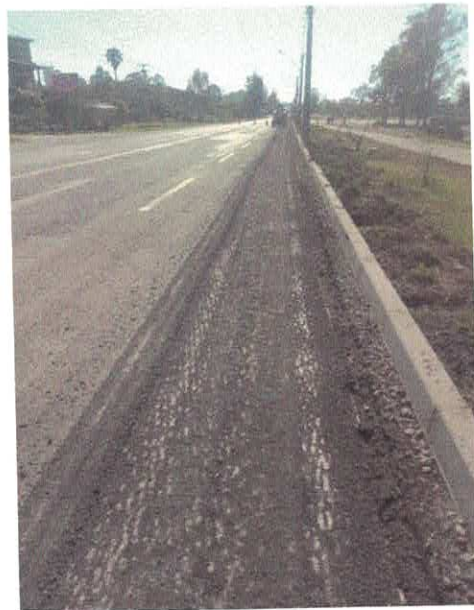
Figura 32 – Execução de fresagem
