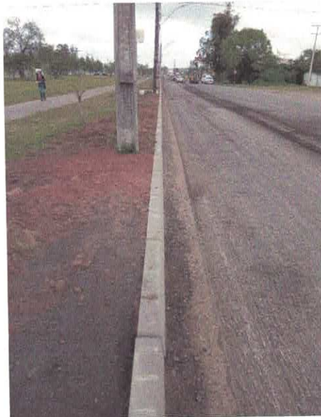
Figura 48 – Execução de meio-fio
