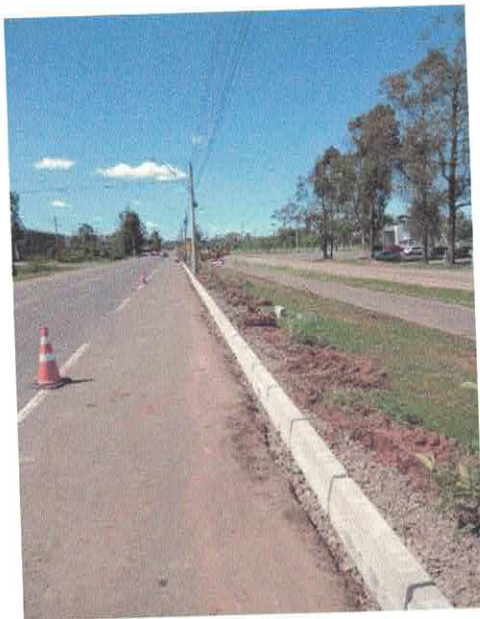
Figura 26 – Execução de meio-fio
