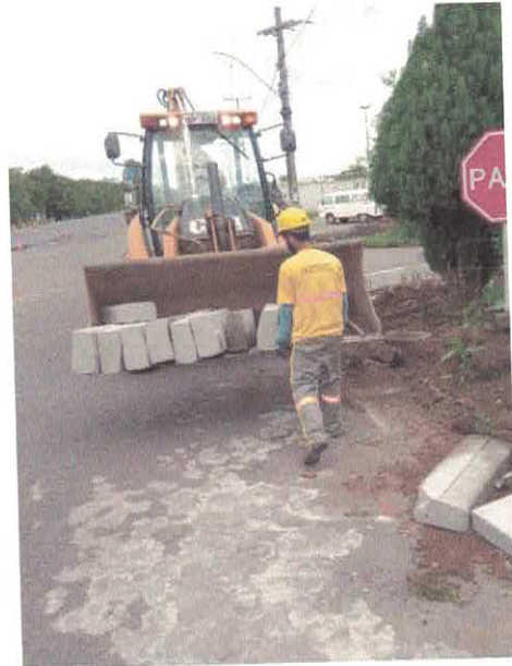
Figura 12 – Execução de meio-fio
