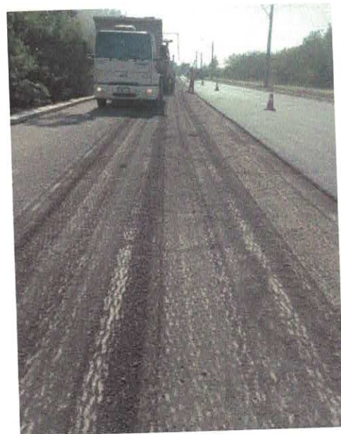
Figura 40 – Execução de fresagem
