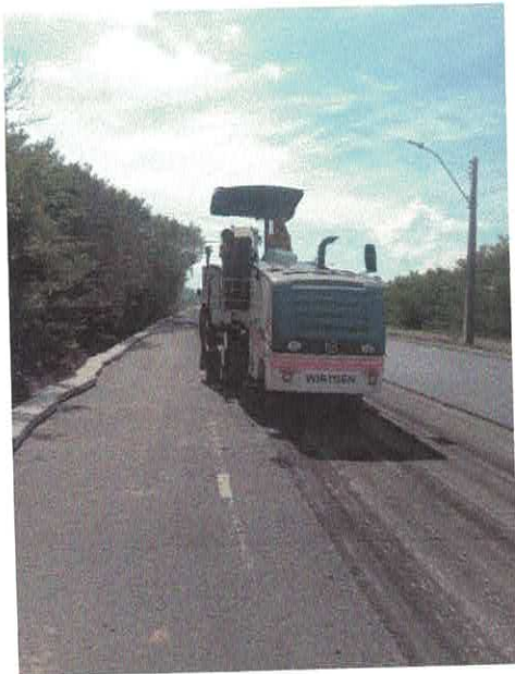
Figura 37 – Execução de fresagem
