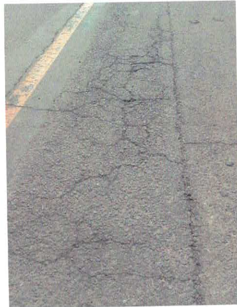
Figura 19 – Recuperação do pavimento
