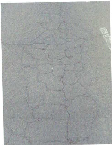
Figura 2 – Recuperação do pavimento
