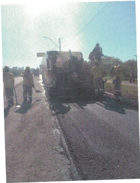
Figura 33 – Execução camada de CBUQ
