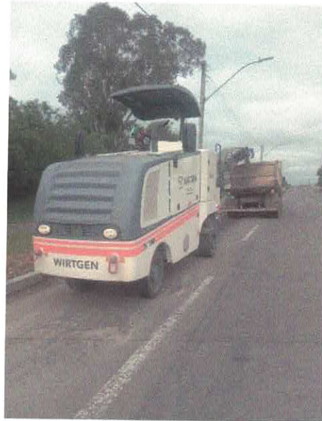
Figura 7 – Execução de fresagem
