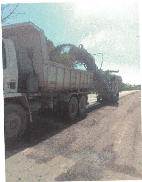
Figura 18 – Execução de fresagem
