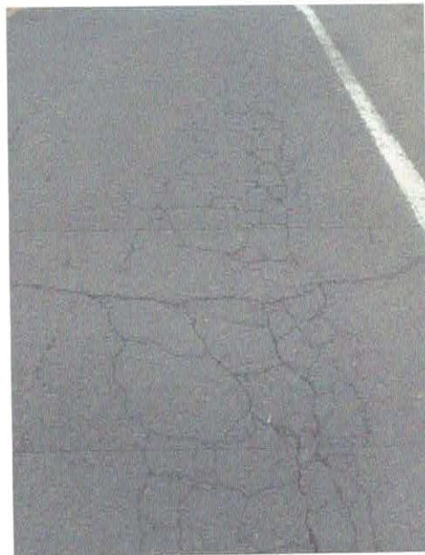
Figura 3 – Recuperação do pavimento
