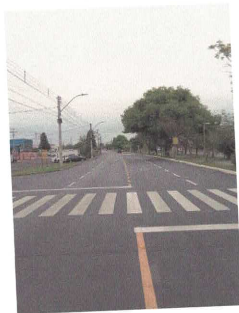
Figura 56 – Execução de sinalização horizontal
