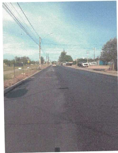
Figura 51 – Execução camada de CBUQ
