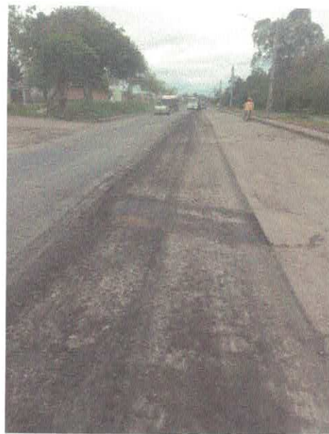
Figura 8 – Execução de fresagem
