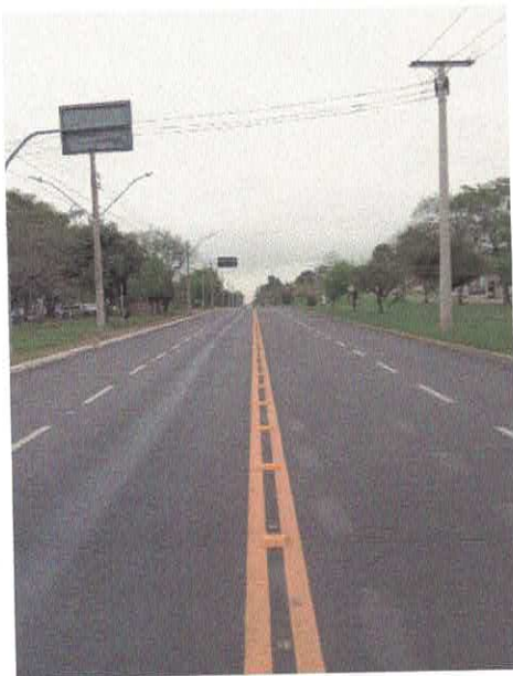
Figura 58 – Execução de sinalização horizontal
