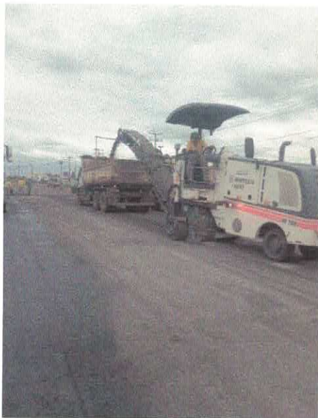
Figura 6 – Execução de fresagem
