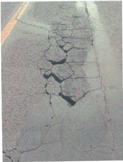
Figura 29 – Recuperação do pavimento
