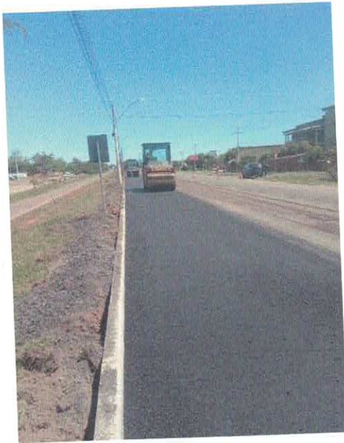
Figura 34 – Execução camada de CBUQ
