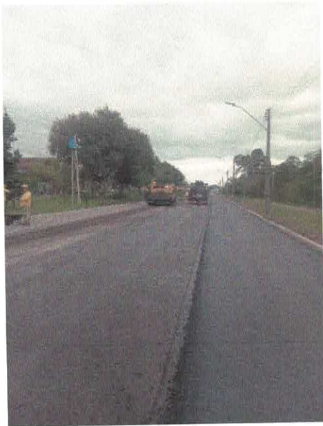
Figura 13 – Execução camada de CBUQ
