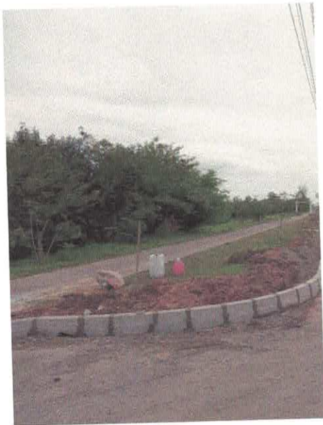
Figura 10 – Execução de meio-fio
