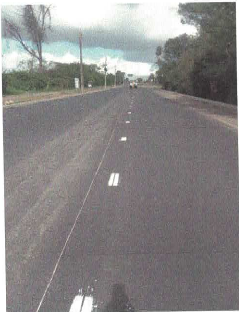
Figura 46 – Execução de sinalização horizontal
