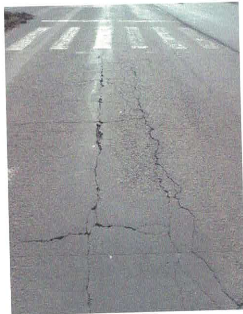
Figura 39 – Recuperação do pavimento
