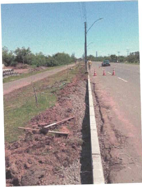
Figura 25 – Execução de meio-fio
