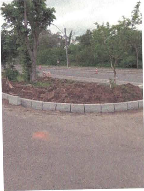
Figura 9 – Execução de meio-fio
