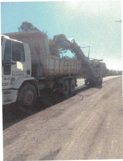
Figura 17 – Execução de fresagem
