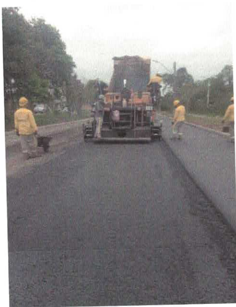
Figura 14 – Execução camada de CBUQ
