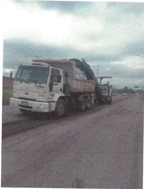
Figura 5 – Execução de fresagem
