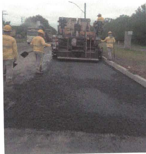
Figura 15 – Execução camada de CBUQ
