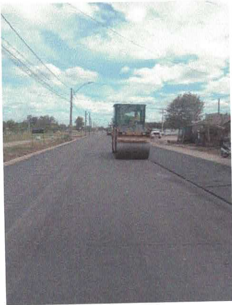
Figura 49 – Execução camada de CBUQ
