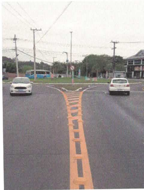
Figura 59 – Execução de sinalização horizontal
