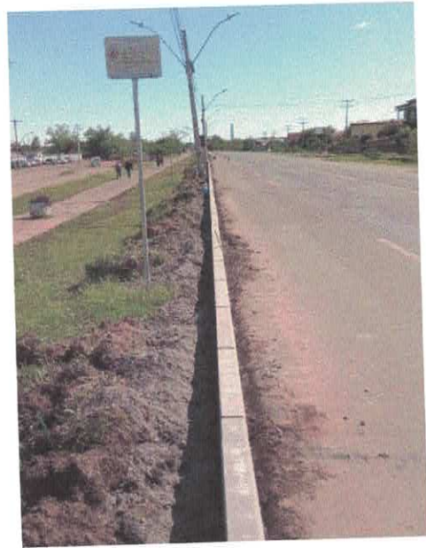
Figura 27 – Execução de meio-fio
