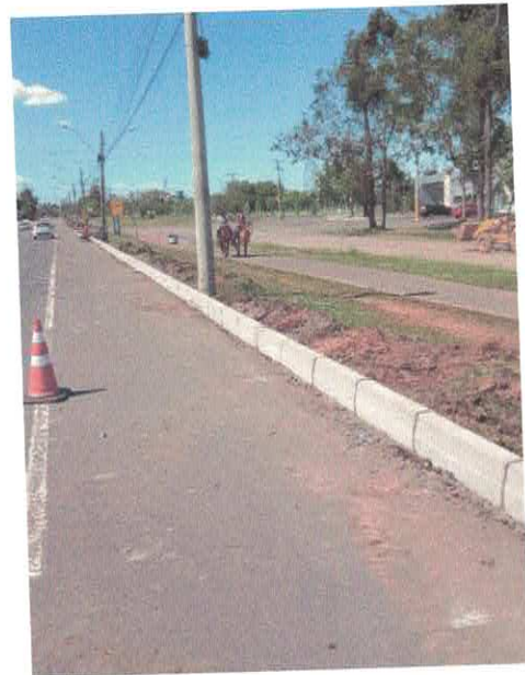
Figura 28 – Execução de meio-fio
