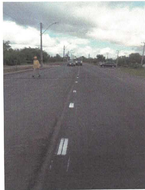
Figura 47 – Execução de sinalização horizontal
