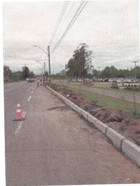
Figura 11 – Execução de meio-fio
