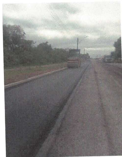
Figura 16 – Execução camada de CBUQ
