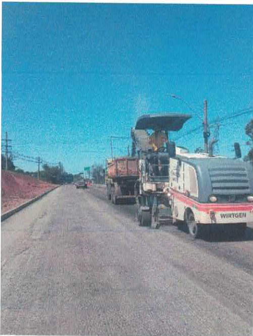
Figura 14 – Execução de fresagem do pavimento
