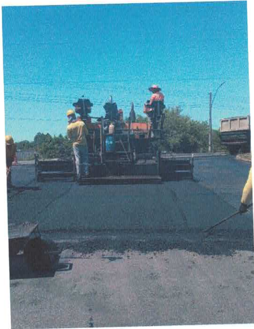
Figura 21 – Execução de camada CBUQ
