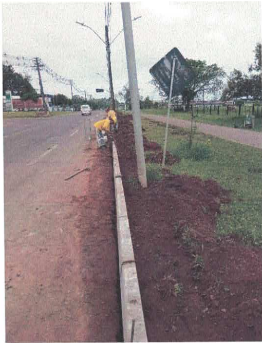
Figura 9 – Assentamento de meio fio
