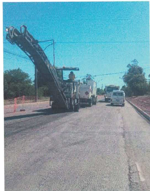
Figura 12 – Execução de fresagem do pavimento
