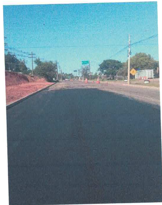
Figura 24 – Execução de camada CBUQ
