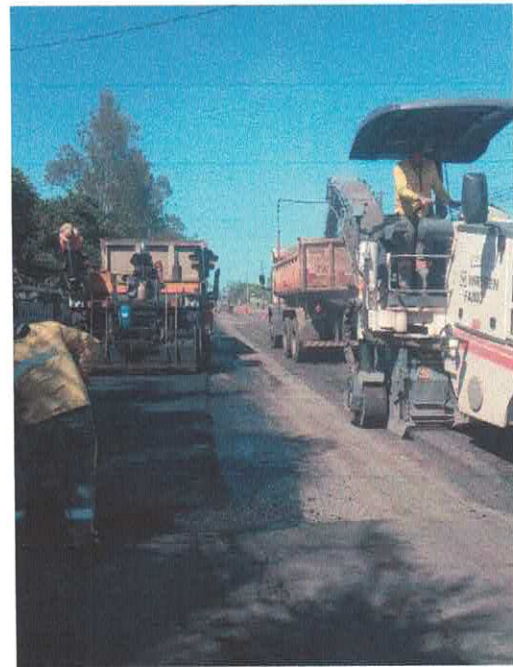
Figura 11 – Execução de fresagem do pavimento
