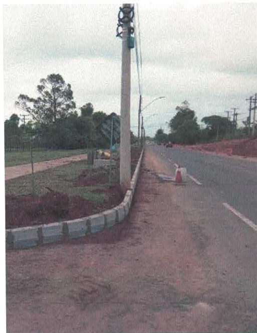
Figura 10 – Assentamento de meio fio
