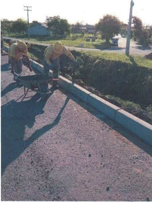
Figura 1 – Assentamento de meio fio
