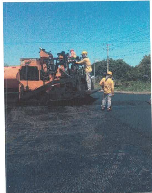
Figura 20 – Execução de camada CBUQ
