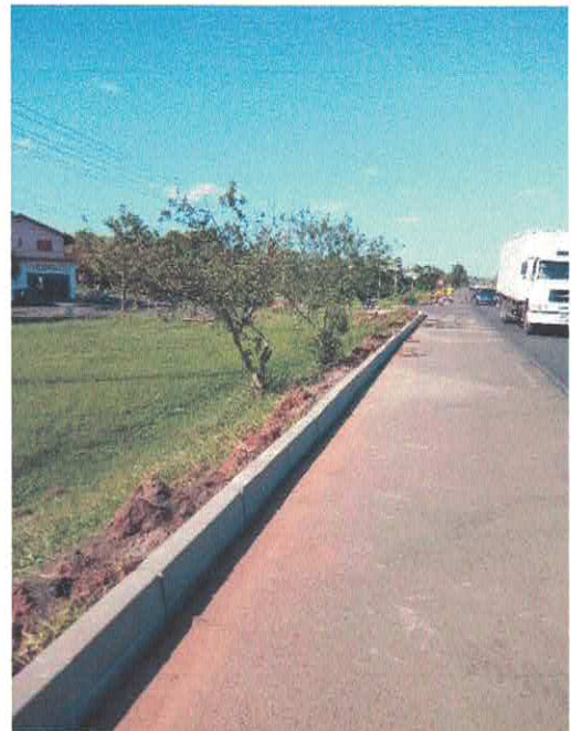
Figura 4 – Assentamento de meio fio
