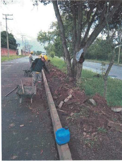
Figura 5 – Assentamento de meio fio
