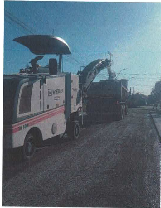
Figura 15 – Execução de fresagem do pavimento
