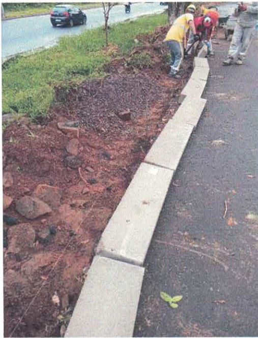
Figura 6 – Assentamento de meio fio
