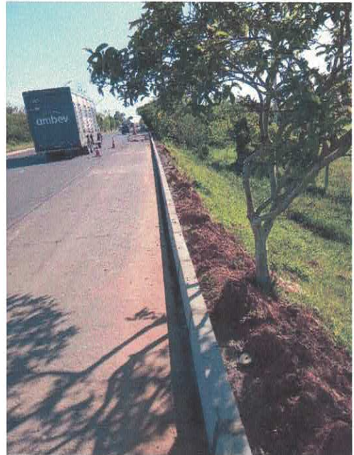
Figura 3 – Assentamento de meio fio
