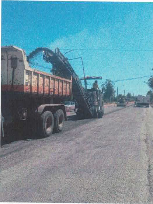
Figura 13 – Execução de fresagem do pavimento
