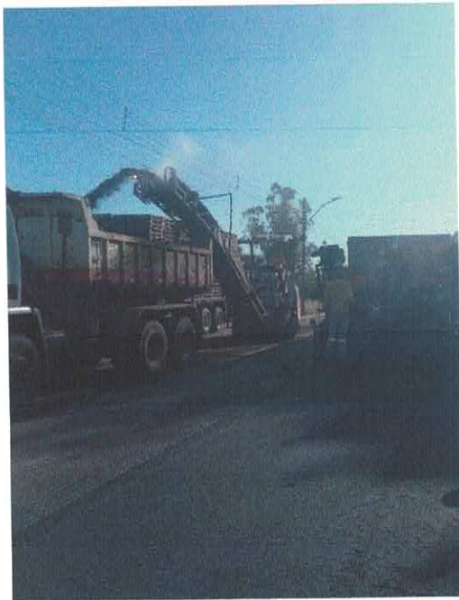
Figura 18 – Execução de fresagem do pavimento
