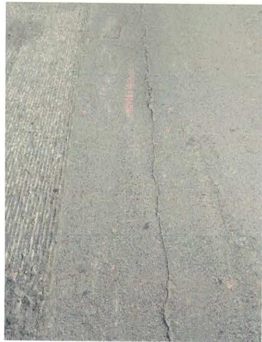
Figura 16 – Execução de fresagem do pavimento
