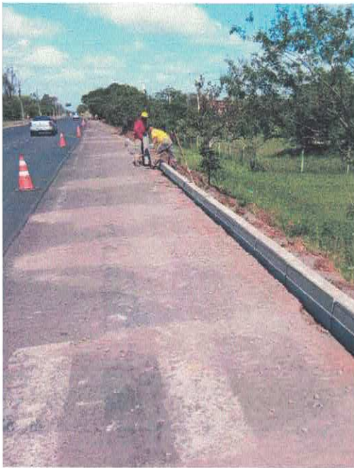
Figura 2 – Assentamento de meio fio
