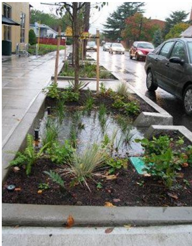
Figura 66 – Jardim de chuva acompanhando faixa de serviço e arborização.
