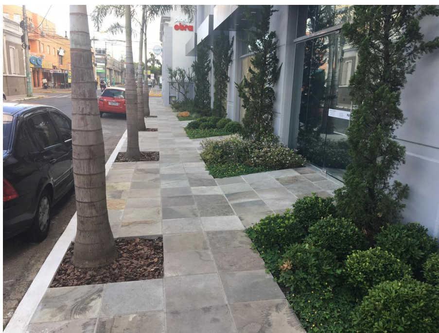
Figura 58 – Jardim em recuo e arborização na zona de serviço com passeio estreito.
