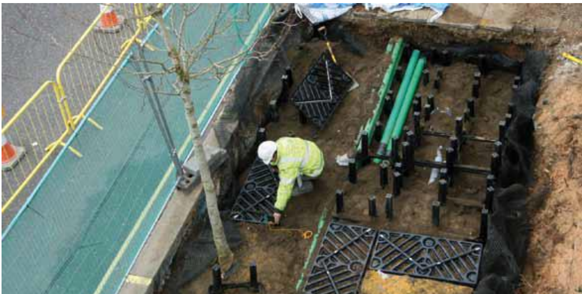
Figura 64 – Construção de células para desenvolvimento de raízes cobertas por placas ou grades.
