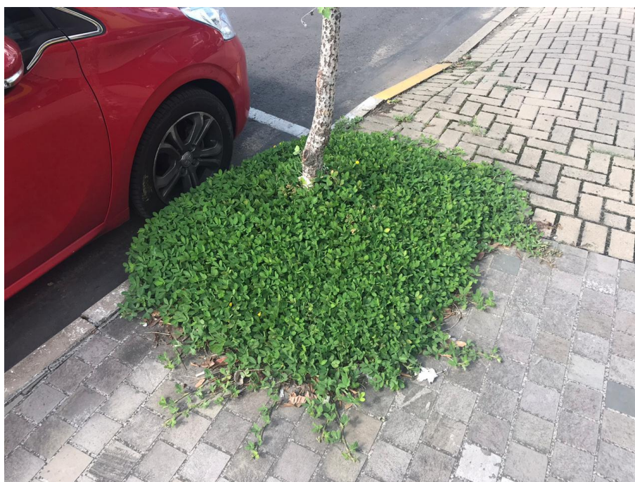
Figura 60 – Canteiro bem dimensionado e vegetado com forração (amendoim forrageiro).
