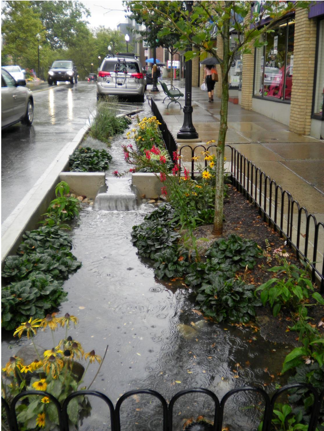
Figura 67 – Jardim de chuva acompanhando faixa de serviço e arborização.
