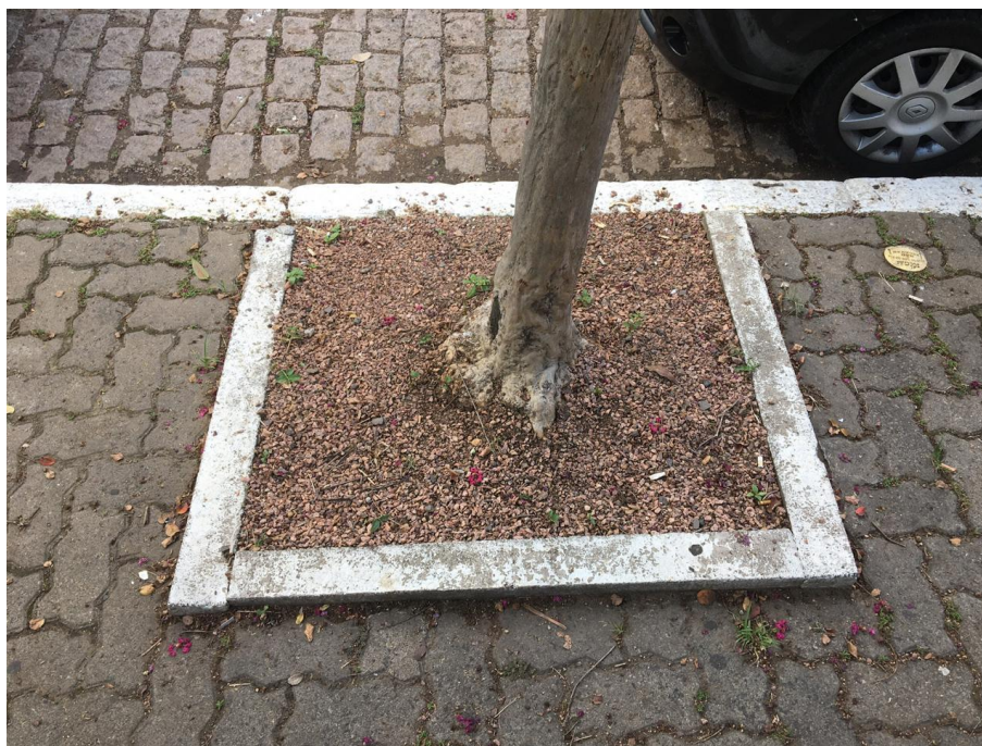
Figura 49 – Defletor com blocos de concreto de meio fio.
